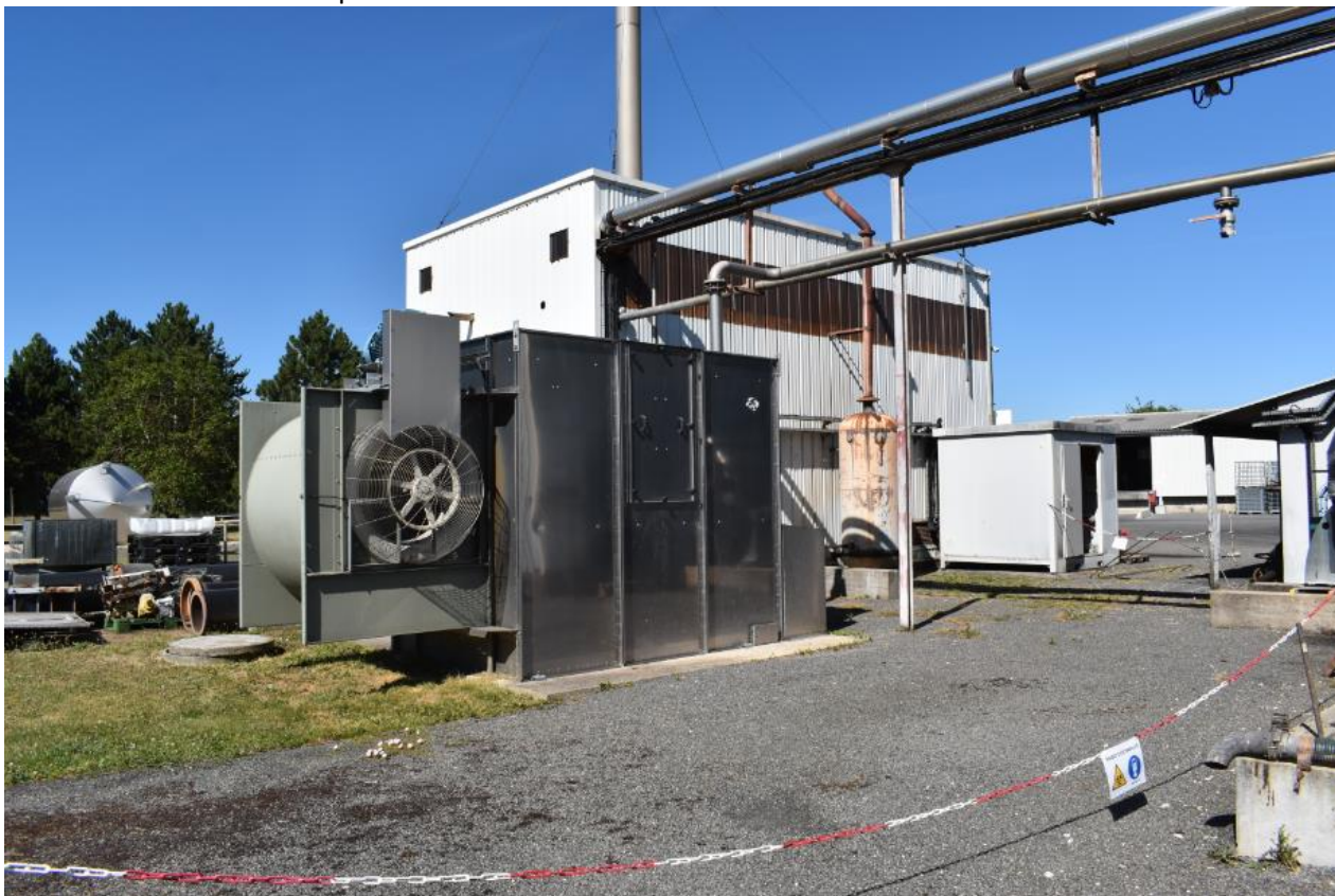
Figure 8 : Prise de vue photographique de la Tour Aéroréfrigérante
